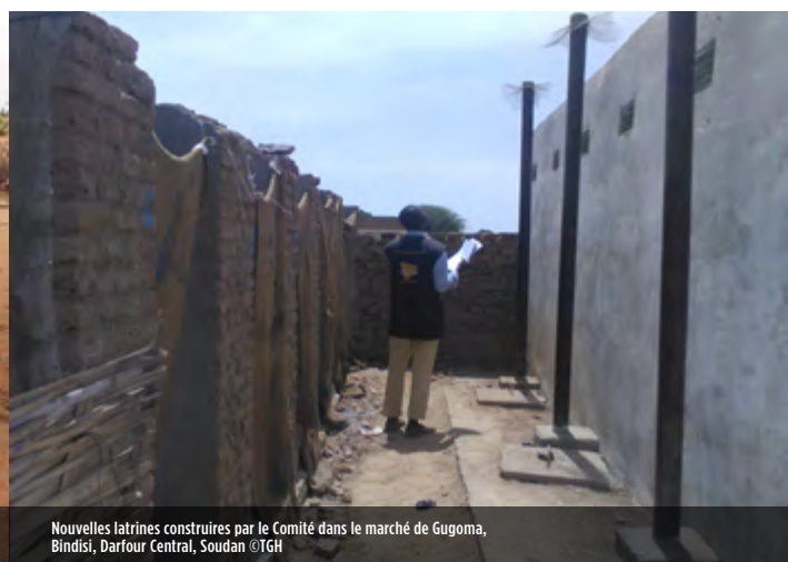
Construction d'une structure de latrines d'urgence, Kreinik, Darfour Occidental, Soudan © TGH
