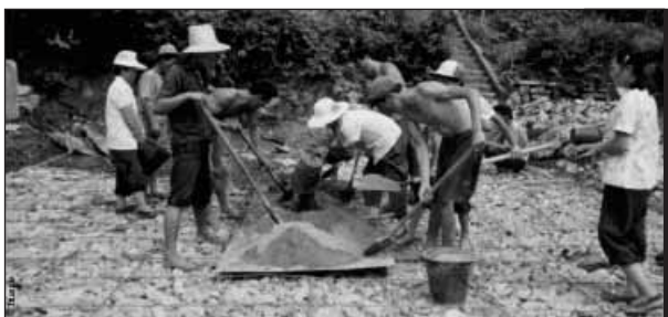
Construction de fumière
