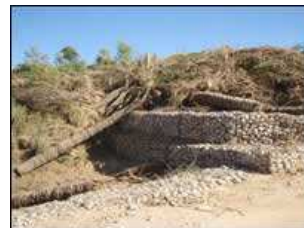
État de l'oued à sec après construction
