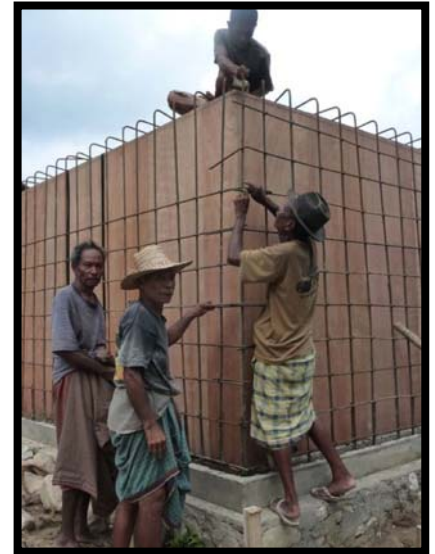
Réservoir d'eau en construction
