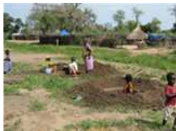
Excavation des fosses de latrines par les communautés - Bindizi
