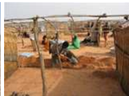
Construction d'abris d'urgence Ryad
