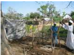
Construction de latrines - Bindizi
