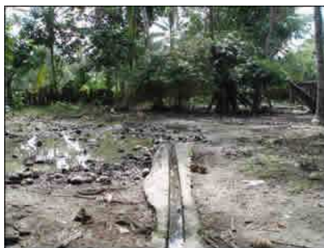
Evacuation des eaux usées à ciel ouvert Photo : Maud Jimenez TGH
