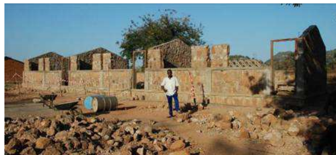
Travaux de construction de l'Ecole de Quanda Djallé
