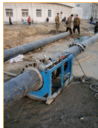
Thermo soudage des tuyaux de gros diamètre effectué par des ouvriers locaux spécialisés.
